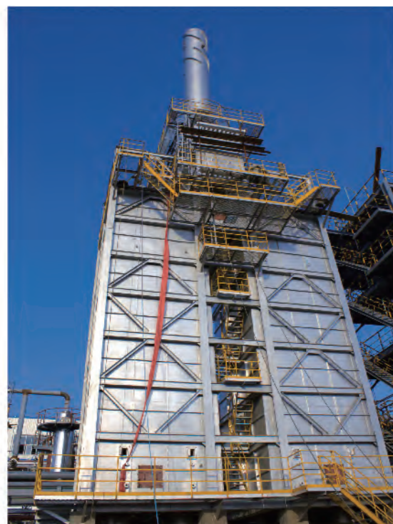
陕西集团20万吨/年甲醇工程 shanjiao group 200000tons/y methanol project
