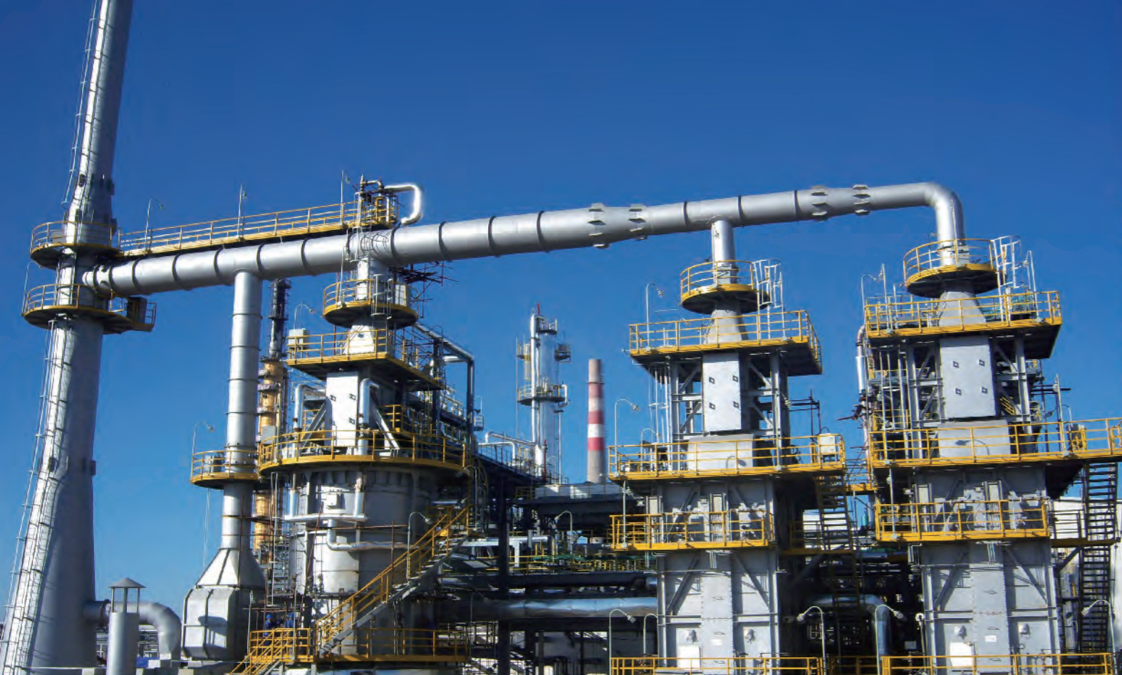
加热炉单元总包工程（内蒙伊泰集团16万吨/年煤制油工程） Heater package EPC project (Inner Mongolia yitai group 160000tons/y coal-to-oil project)
