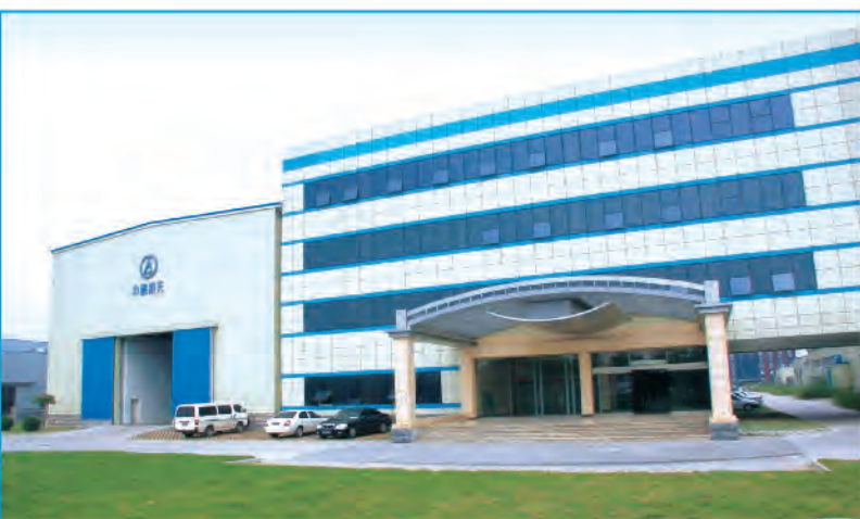
生产基地 Fabrication center
