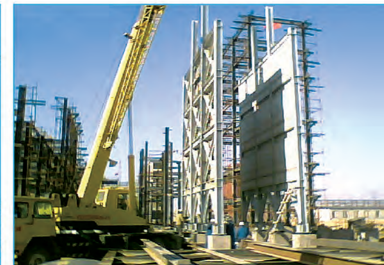
国内工程施工现场吊装 Domestic Lifting On Site
