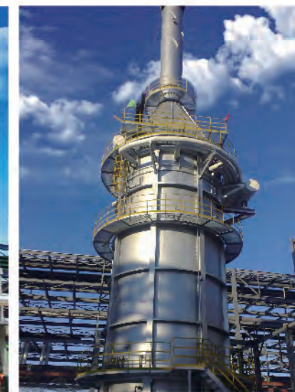
内蒙古大唐克什腾煤制LNG加热炉 Heater for coal furnace LNG of Inner Mongolia Datang Keshiketeng
