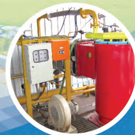
燃烧系统改造 Combustion System Reconstruction
