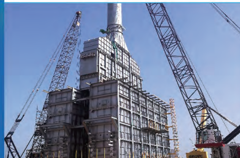
国际工程施工现场吊装 International Lifting On Site
